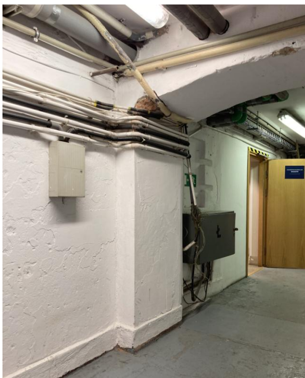
Widok stanu istniejącego – instalacje sanitarne do umieszczenia w kanale technicznym i za ścianką ażurową.
