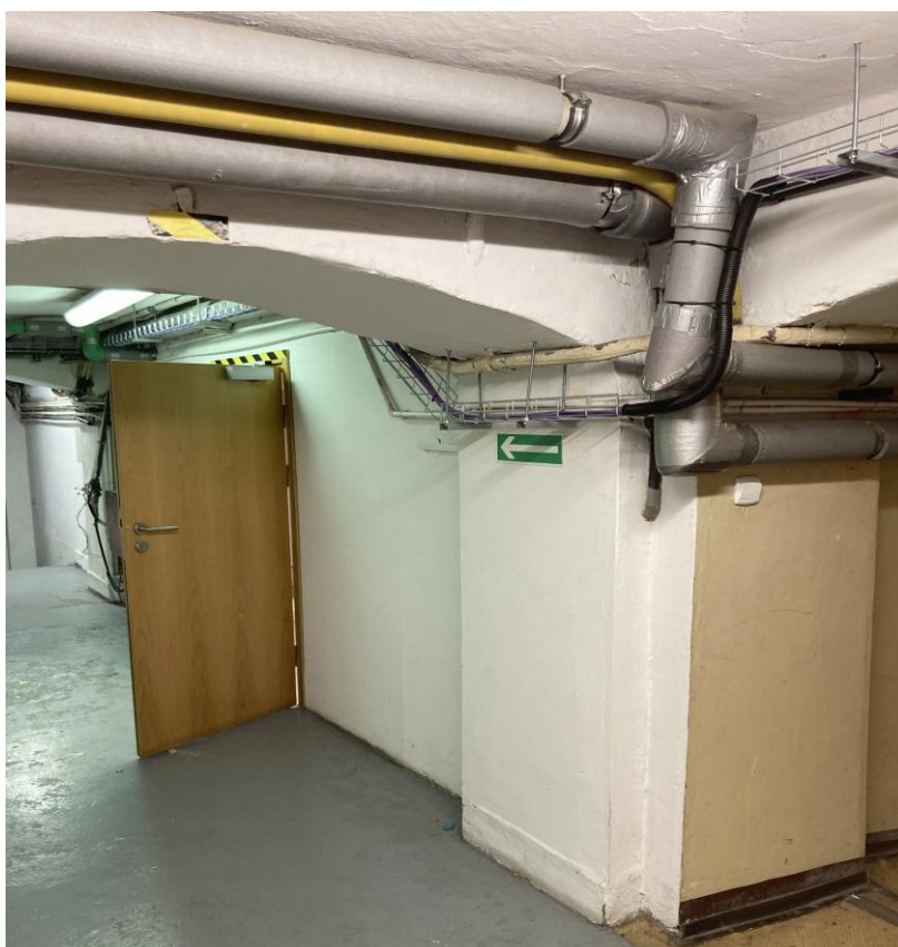
Widok stanu istniejącego – instalacje sanitarne do umieszczenia w kanale technicznym.
